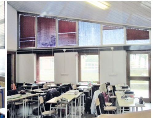
Aula con superfici vetrate pitturate per ridurre la luminosità durante l'utilizzo della LIM.
